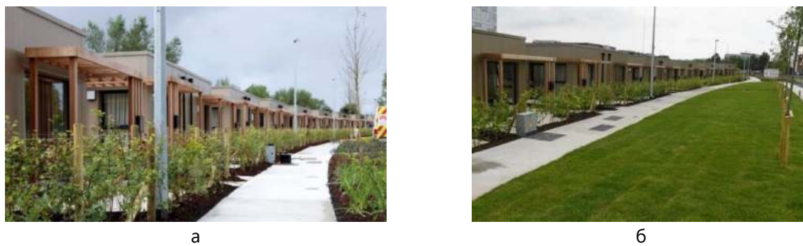
Рис. 8. Екстер'єр модульних містечок Rapid Build Housing в Ірландії, 2023: а – у Дорлі Парк, Слайго; б – у Махоні, Корк [17]
