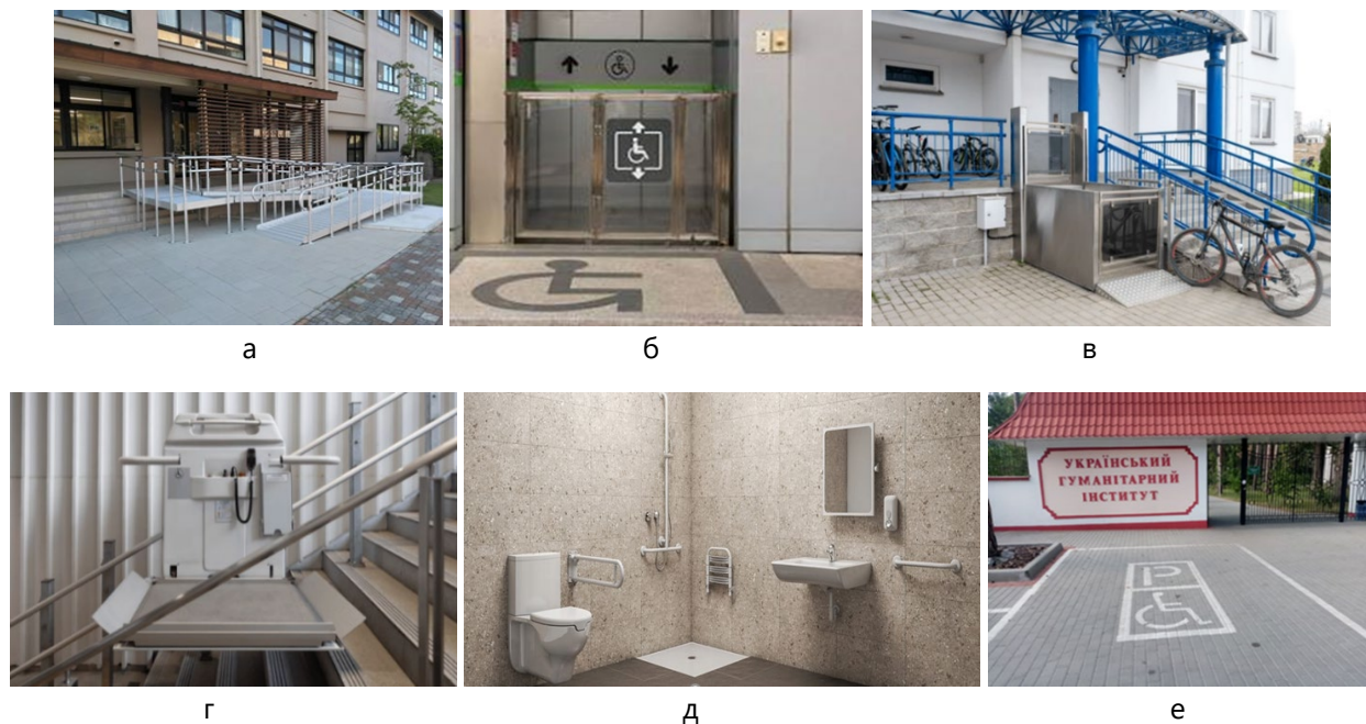
Рис. 1. Ергономічні рішення інклюзивного простору: а – інклюзивний пандус; б – ергономічний ліфт для людей з інвалідністю; в – інклюзивний електричний підйомний пристрій для людей з інвалідністю біля споруди; г – інклюзивний підйомний пристрій над сходами; д – ергономічний інклюзивний туалет; е – інклюзивна стоянка автомобілів біля будівлі
