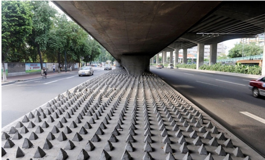
Рисунок 9. Бетонні шипи під експресвеем Хуанши, Китай
